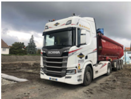
La noria des camions. Ils étaient parfois 4 sur le chantier
