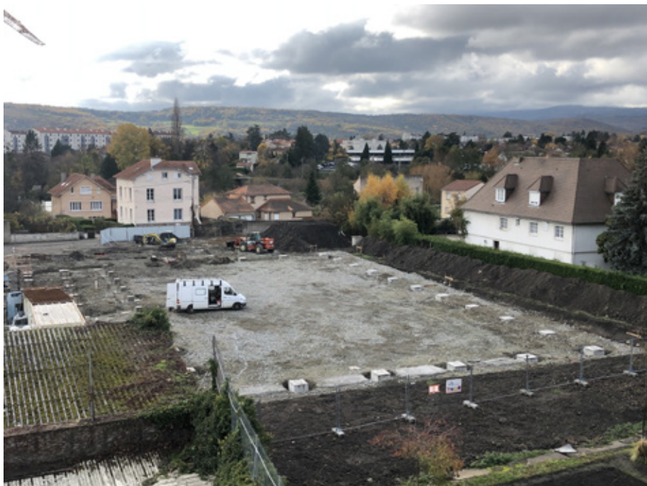
Vue générale du chantier
