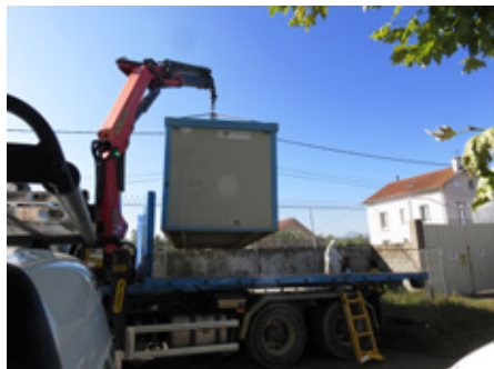
Le chantier commence par la dépose des Algéco® destinés aux ouvriers
